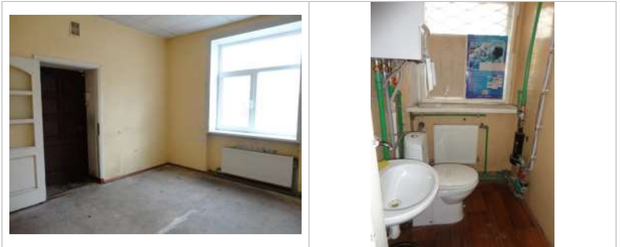
Skats uz vērtējamā objekta divām ieejām un otrās telpu grupas iekštelpām/ sanitārtehnisko telpu un apkures telpu.
